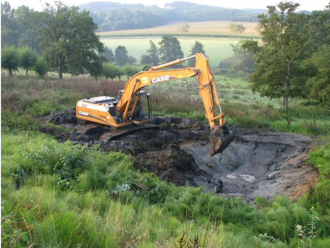
Figuur 16: Ruimen van een poel = de sliblaag uitscheppen tot op de minerale bodem. Het overtollige materiaal wordt meestal in de directe omgeving uitgespreid. Voedselrijk slib kan snel aanleiding geven tot verruiging. Om dit te vermijden kun je direct het snel groeiende Italiaans raaigras inzaaien.
